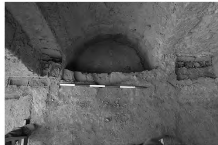
Abb. 43: Raum 31aO/M1, Badebecken WB-B2 in der O-Mauer
