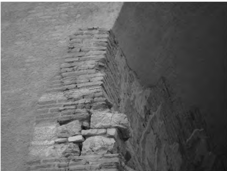
Abb. 75: Ansatz der Bogenfensteröffnung im Apsidensaal 8
