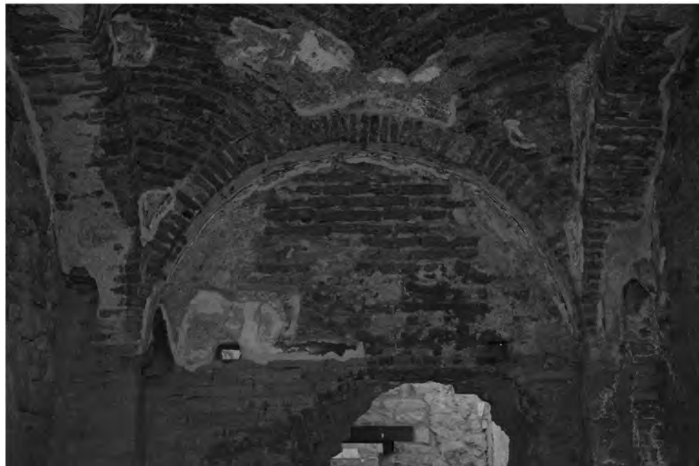
Abb. 3: Tonrohre als Rauchabzug im Bad 31aO/M2
