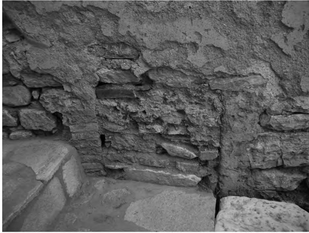
Abb. 1: STG 1, vermauertes Praefurnium zum Raum 31aO/M2
