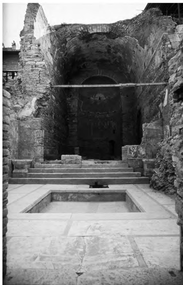
Abb. 7: Raum 36, Bodenwasserbecken WB-A6
