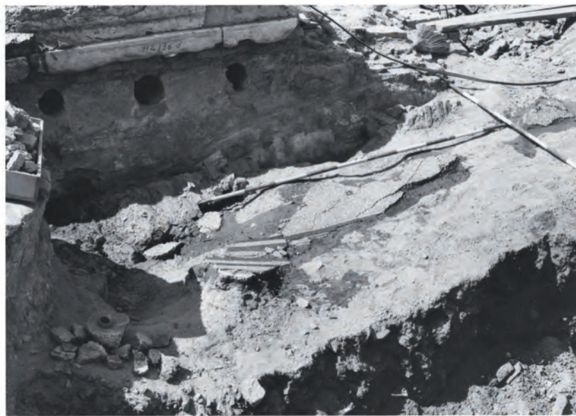
Abb. 2: 36d.1, Mosaik bei Freilegung
