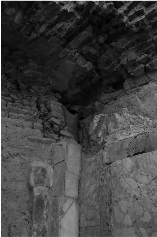
Abb. 41: Raum 36c, Fallrohr in NW-Ecke
