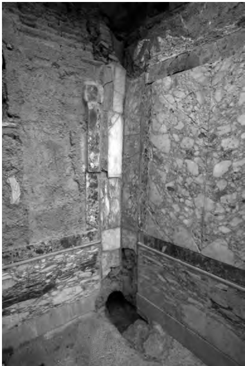
Abb. 11: Raum 36c, Fallrohr in NW-Ecke
