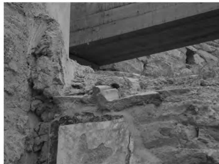
Abb. 45: Peristylhof 31a, Apsidenbecken WB-B4, Reste der Ziegeldeckung
